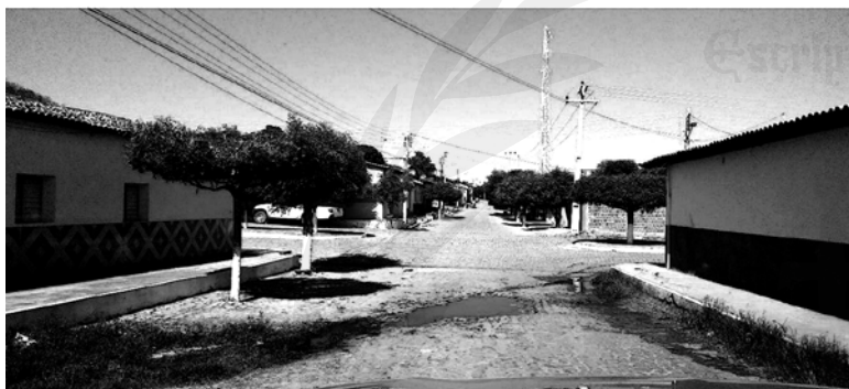
Foto 06 – Escoamento dos dejetos a céu aberto (Sede)
