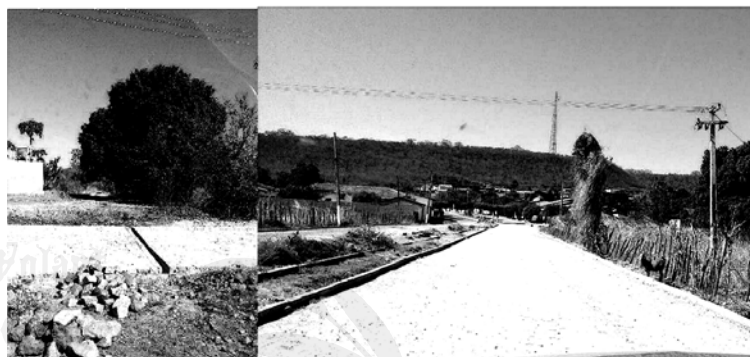
Foto 07 – Trecho de rede de drenagem do município.
