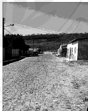
Foto 01 – Pavimentação de ruas na área urbana.
