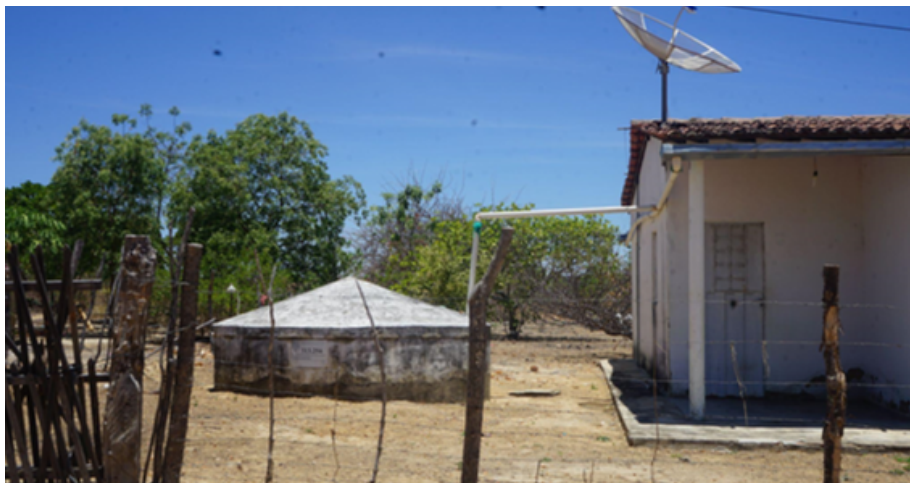
Imagem 1: Cisterna de placas implantada em propriedade rural.
