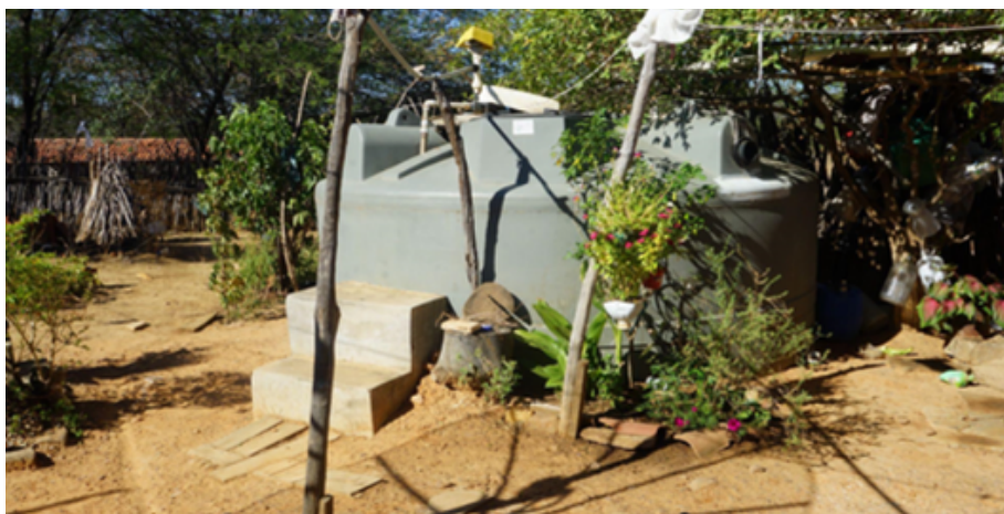
Imagem 2: Cisterna domiciliar de polietileno instalada em propriedade rural.
